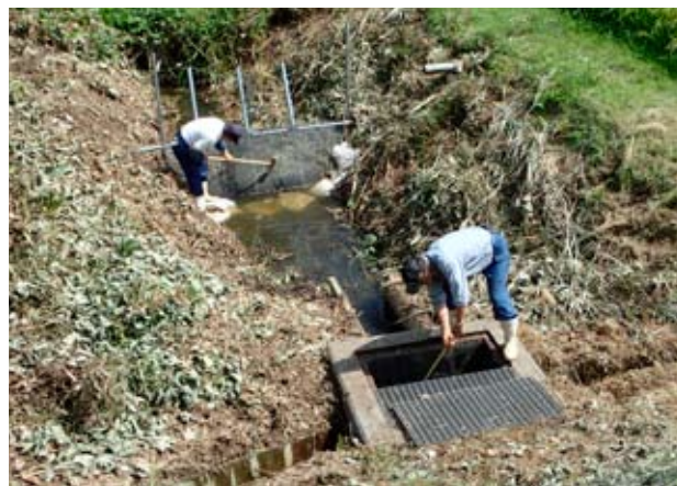
水抜きの前、外来魚を流下させないよう流下防止柵を2段階で設置
