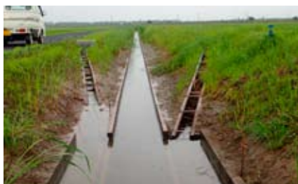
試作を重ね、ほぼ最終形に到達した水田魚道
