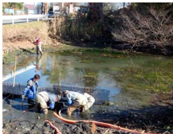
ポンプ排水開始の前に、ゴミ除けネットを配置
